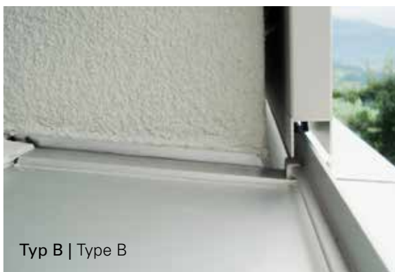
Fensterbankführung | Window sill guide
